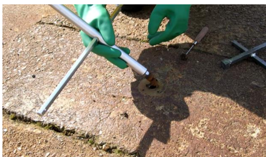
[3. 調整弁に付いた汚れを落とす]
