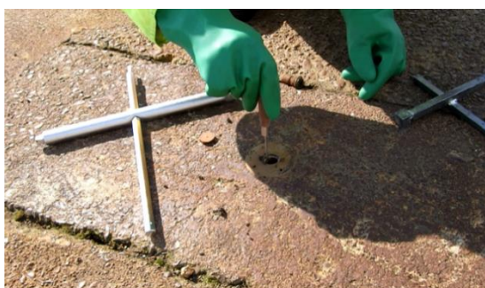
[4. 千枚通しを使い、ノズルの中の汚れを落とす]
