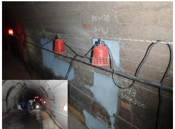
第二放水路 工事の様子と補修後のトンネル壁面
