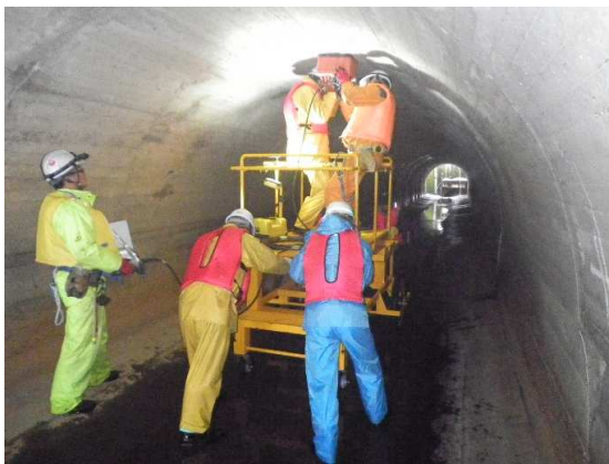
第一放水路 詳細調査の様子(レーダ探査)
