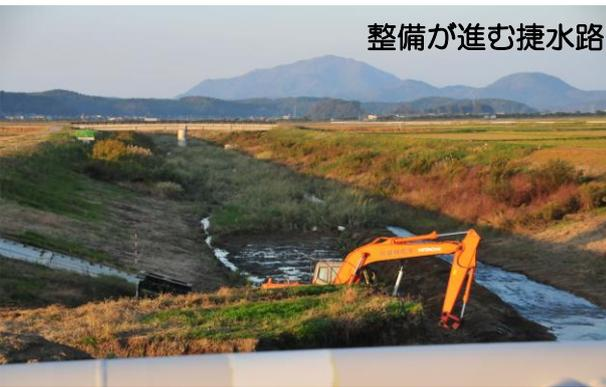
また、現川は市街地の雨水排水や防火用水を確保する機能があるため、普段は現川に水を流し、豪雨時は現川に流しきれない水を市街地上流付近に設置する分流堰で捷水路へ分水する計画で工事を進めており、平成20年代後半の通水を目指しています。
