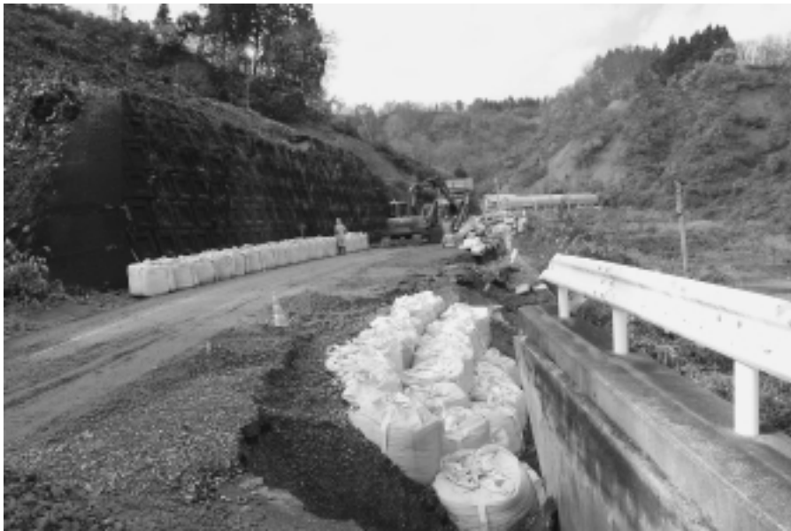
復旧工事の進む現場
