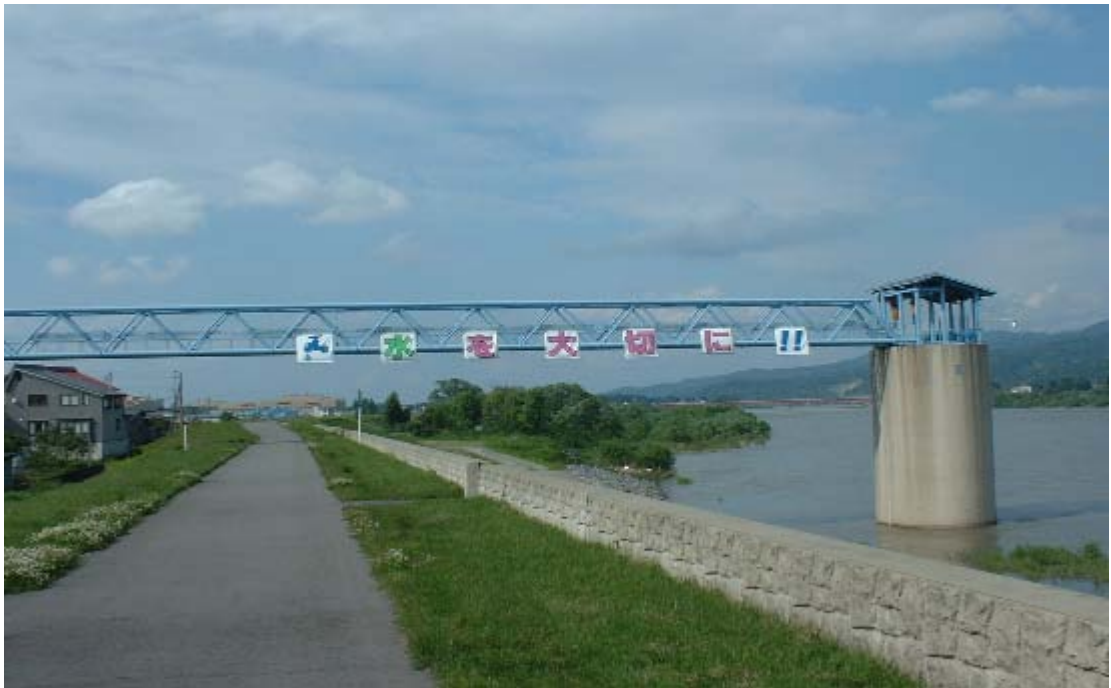
小千谷浄水場水管橋
