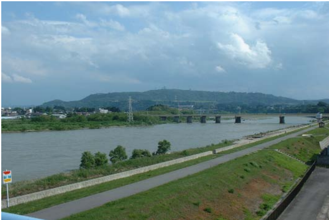
小千谷浄水場水管橋より信濃川、山本山を望む
