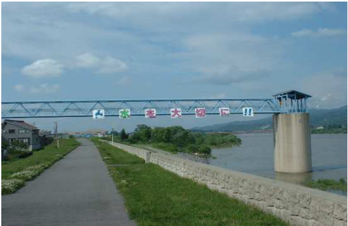
小千谷浄水場水管橋
