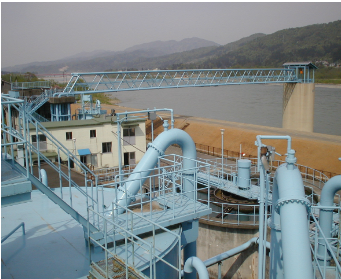
小千谷浄水場より、信濃川取水塔を望む
