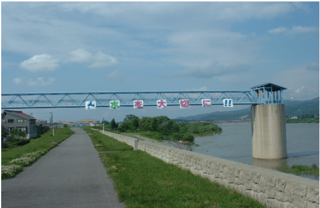
小千谷浄水場水管橋・取水塔
