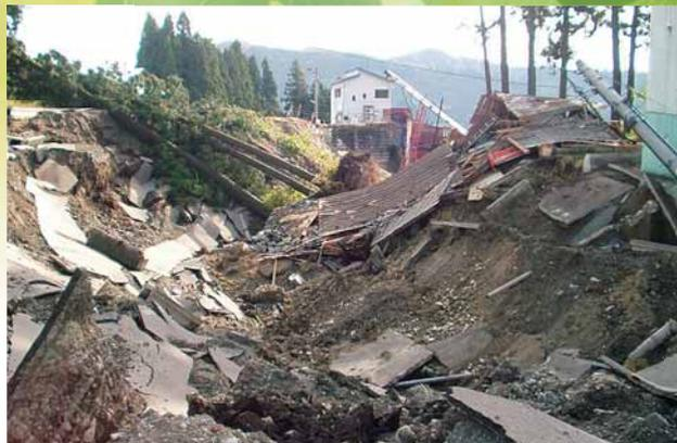
地盤が崩壊した水道施設(卯ノ木)
