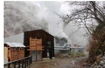
温泉から湧出する約120°Cの蒸気・熱水を利用したバイナリー発電事例 (十日町市)
