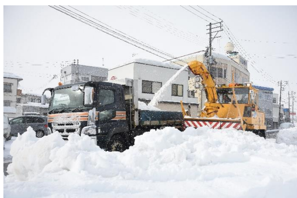
機械除雪による交通の確保
