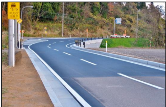
(主) 県道 小千谷十日町津南線 小真人沢地内
