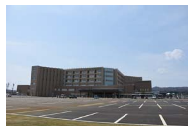
「JA新潟厚生連小千谷総合病院」開院
