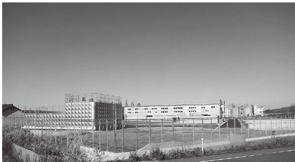
新浄水場外観
