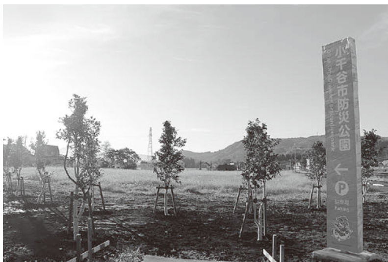
整備中の防災公園
