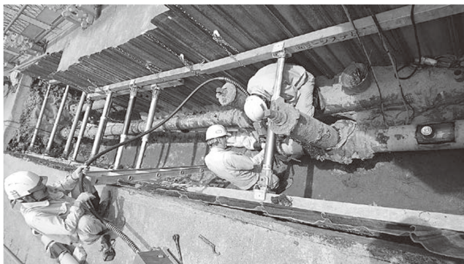
ガス管の維持補修工事
