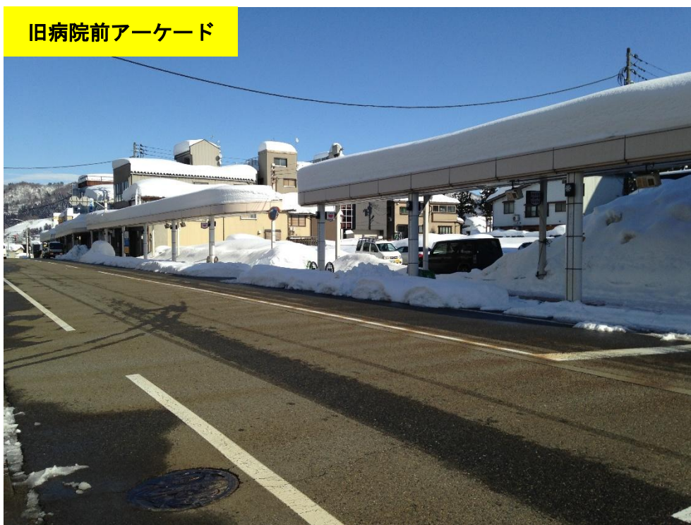
旧病院前アーケード 除雪後
