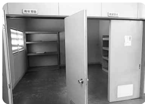
旧塩殿小学校体育館用具室
