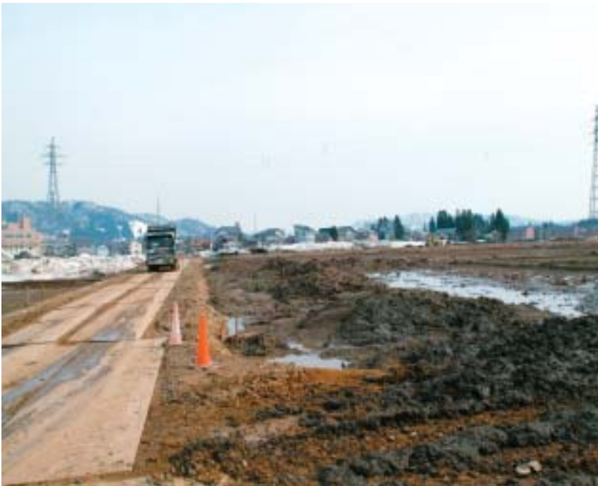
造成が進む千谷地内の住宅移転用地
