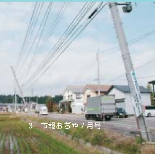
傾く電柱 桜町
