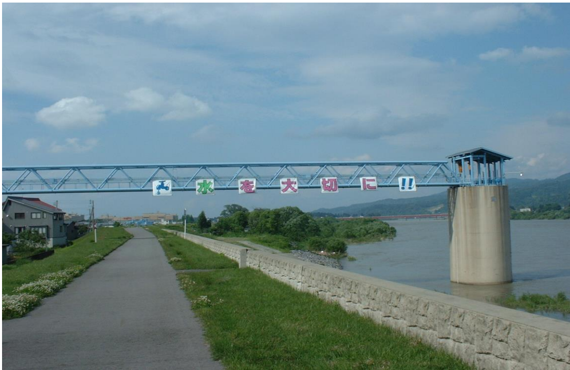
小千谷浄水場水管橋
