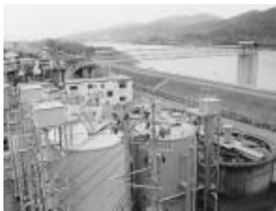
ガス水道局浄水場
