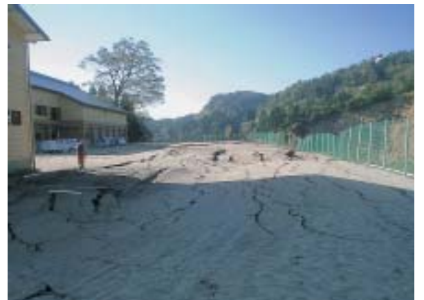
陥没し亀裂がはしる東山小学校グラウンド
