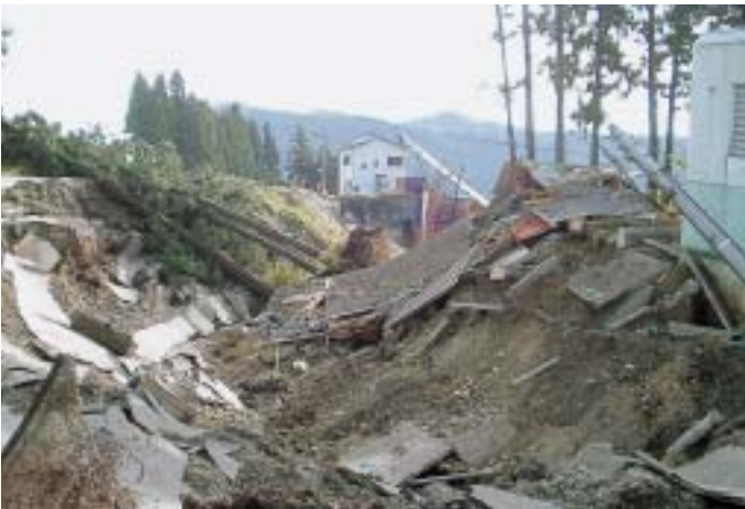
大きな被害のあった塩殿浄水場
