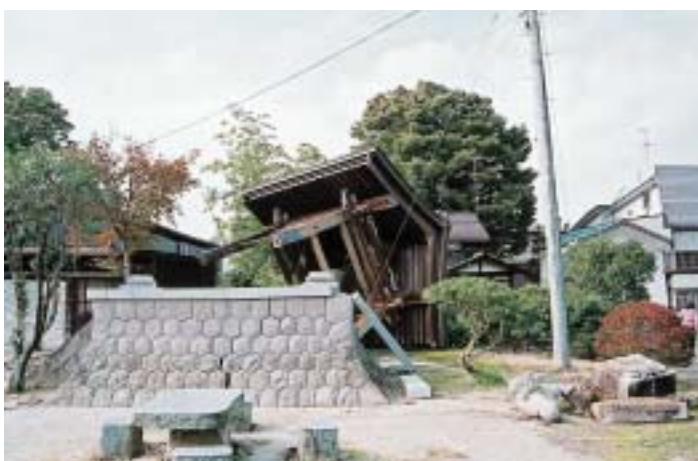
寺院も大きな被害（照専寺）
