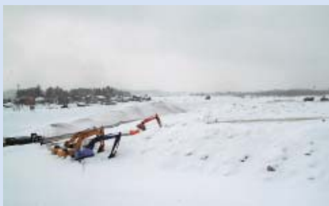
ダンプが行き交い重機が動く越の大橋近くの雪捨て場
