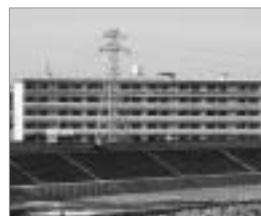
市営信濃川住宅
