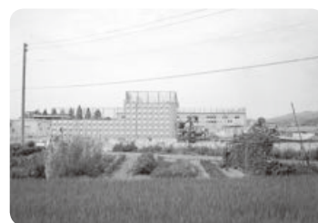
完成した新浄水場
